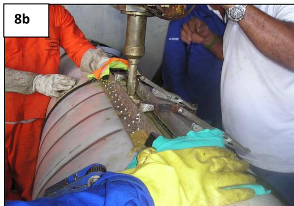
**Figura 8.** Projeto PDET Águas Rasas - Petrobras. Revestimento de juntas de campo com mantas termocontráteis de polipropileno e isolamento térmico com poliuretano sólido.
