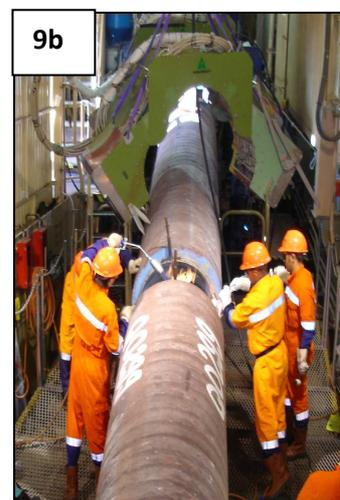
**Figura 9a.** Processo típico de instalação de mantas de polipropileno a bordo de uma balsa de lançamento de dutos. **9b.** Foto de instalação de manta de PP em uma linha de produção de uma balsa de lançamento tipo “S”.
